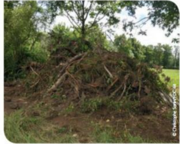
▲ Le tas de souches terreuses est terminé
